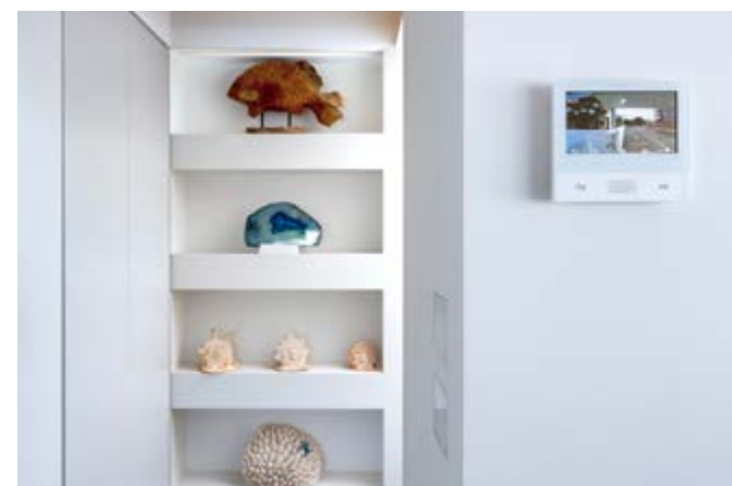
PER L'IMPIANTO videocitofonico sono stati scelti i posti interni della linea TAB con display da 7 pollici. Sono due i monitor presenti, uno per piano
